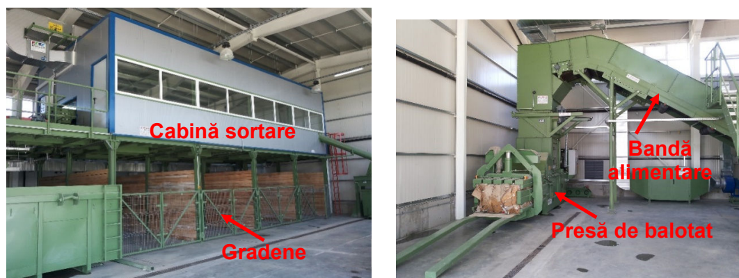
Figura 4.8. Imagini din Stația de sortare lanca
