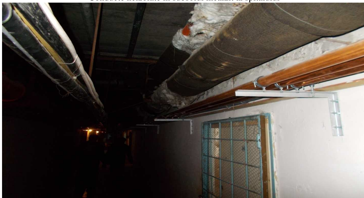
Conducte neizolate in subsolul incalzit al spitalului
