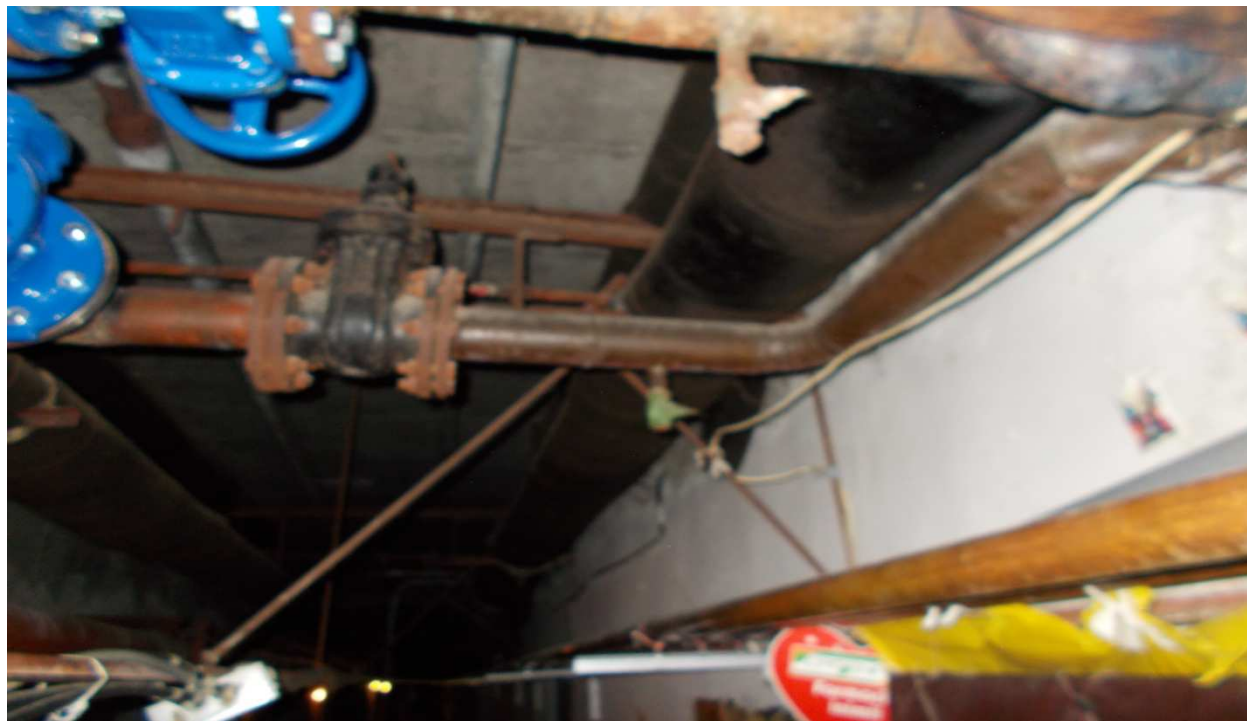
Conducte neizolate in subsolul incalzit al spitalului
