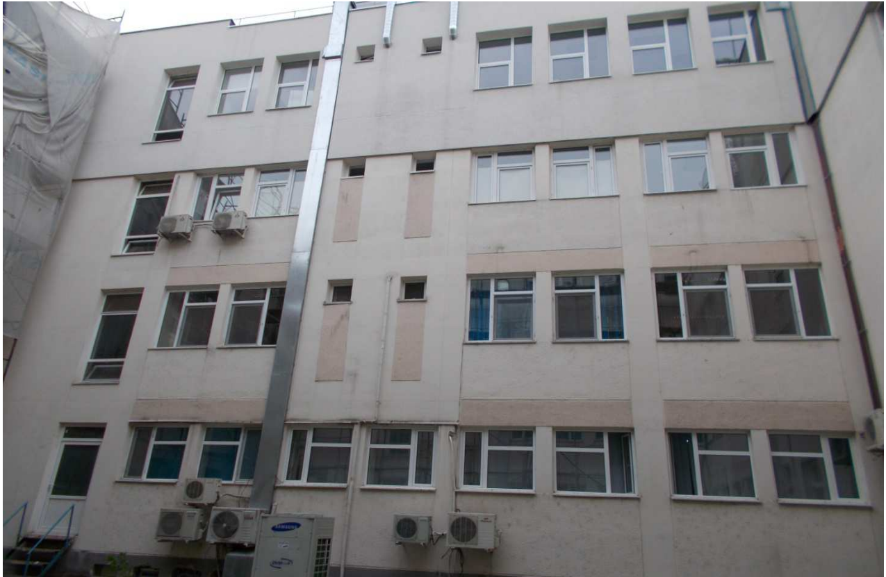
C5 - Fatada N in curte interioara C4,C5,C6 si C7( se observa instalatia de climatizare)
