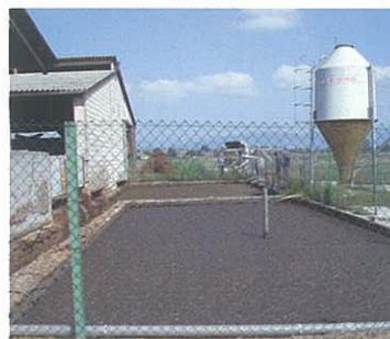
Bazin de colectare gunoi semilichid și sistem centrifugal
